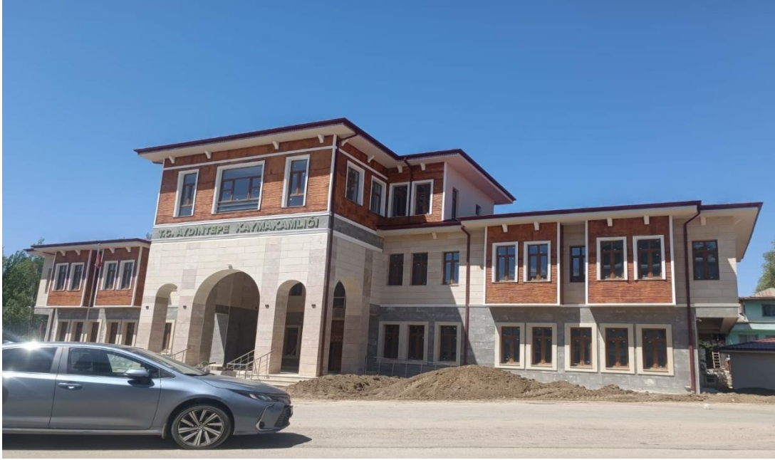
Aydıntepe İlçesi Hükümet Konağı Yapım İşi
