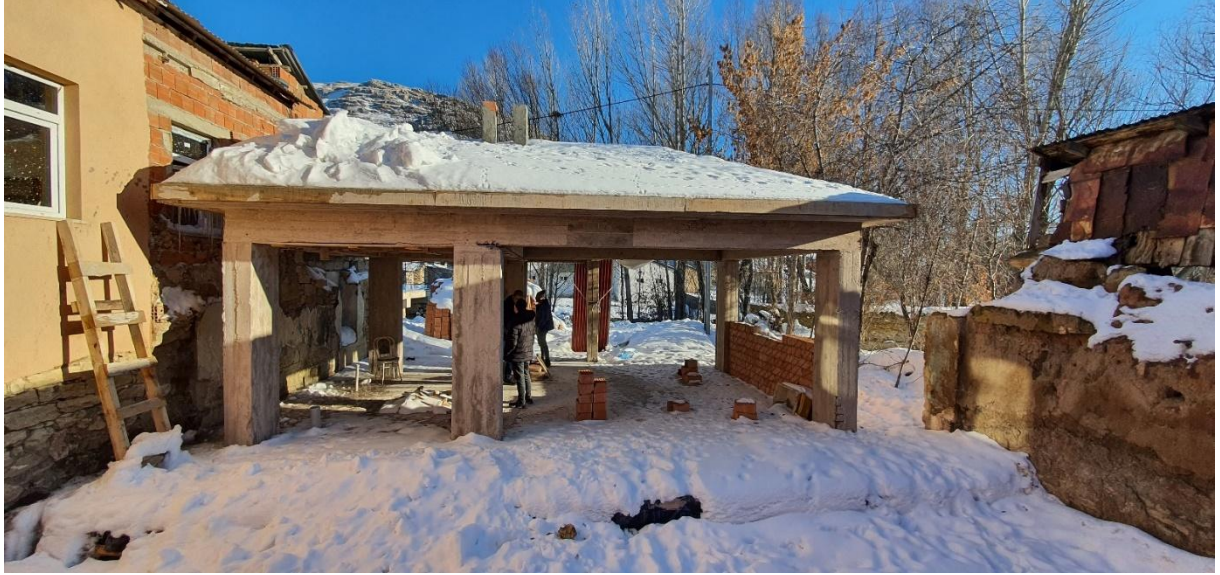
Kırkpınar Köyü Muhtarlık Hizmet Binası
